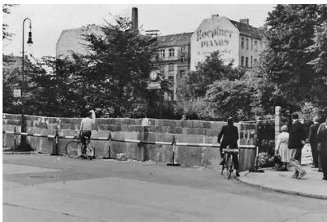
Mauerbau in der Harzer Straße
